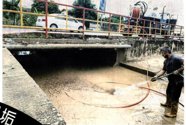
■工人出动高压水枪，彻底把顽固的陈年旧泥清理掉。
