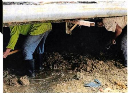
■路下和桥下的排水道也不能忽视，工人以铲子把顽固污泥铲松。
