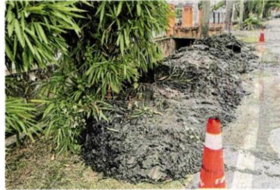
■在刘贵城的监督下，工人又从沟渠内，挖出许多泥沙。
